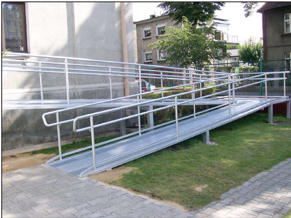
Podjazdy to dobry sposób na walikę z architektonicznymi barierami.
