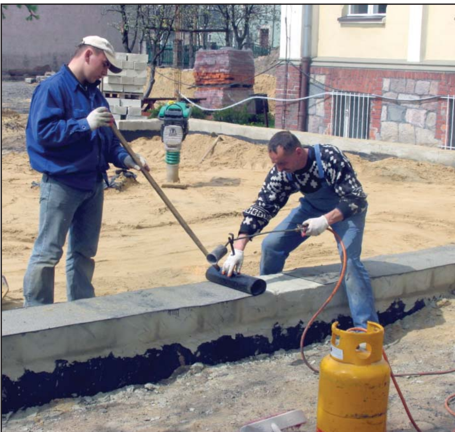
Rozbudowa Liceum w Śmiglu to największa, tegoroczna inwestycja budowlana powiatu.
