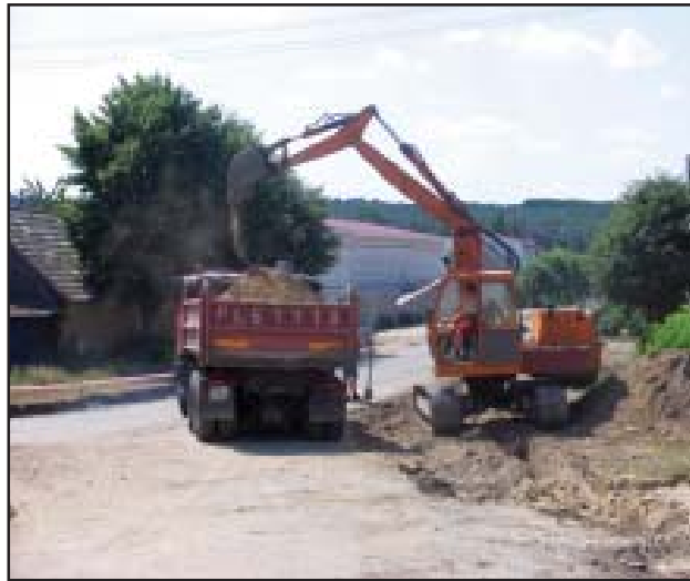
Droga w Lubiniu będzie miała nową nawierzchnię.
