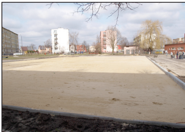
Przy kościańskim Zespole Szkół nr 2 trwa budowa ogólnodostępnego, wielofunkcyjnego boiska sportowego
