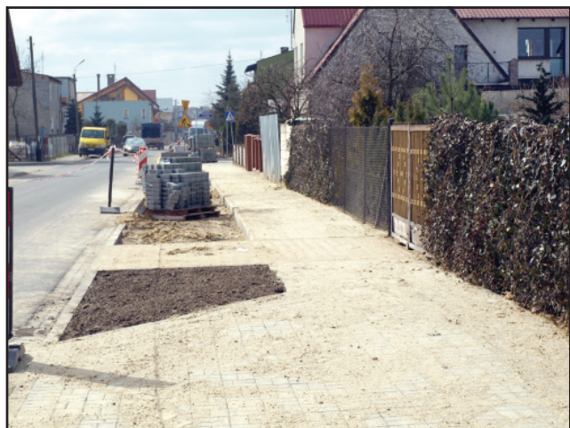
Na ulicy Krasickiego powstaje brakujący chodnik
