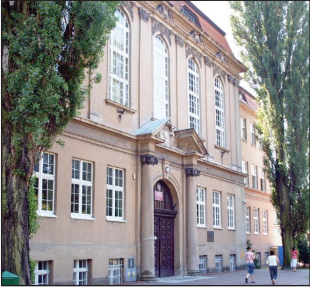
W I Liceum Ogólnokształcącym w Kościanie w ramach termomodernizacji wymieniono 61 okien.
