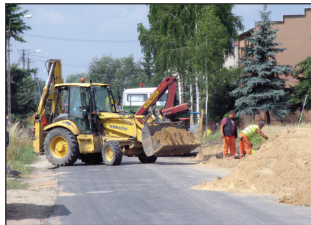
Trwa przebudowa drogi w miejscowości Pelikan.
