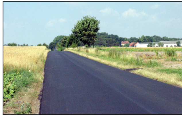
W Kurowie wyłożono nową nawierzchnię na kilometrowym odcinku.
