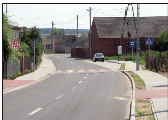
W Jurkowie przebudowano zakręt.
