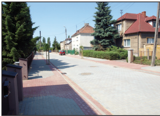
Na ulicy Kopernika wykonano nawierzchnię wraz z chodnikami
