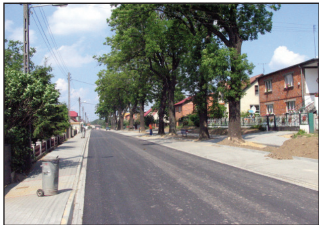
W Czaczu zakończono wylewanie nowej nawierzchni bitumicznej.
