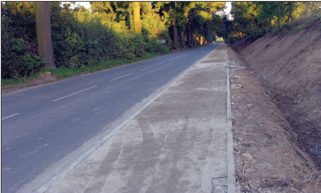
Dobiegają końca prace przy budowie ścieżek rowerowych.
