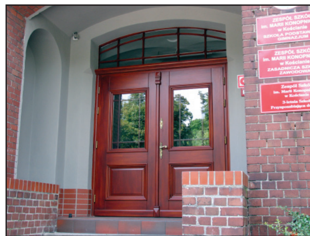
Do głównego budynku Zespołu Szkół im. M. Konopnickiej prowadzą nowe drzwi.
