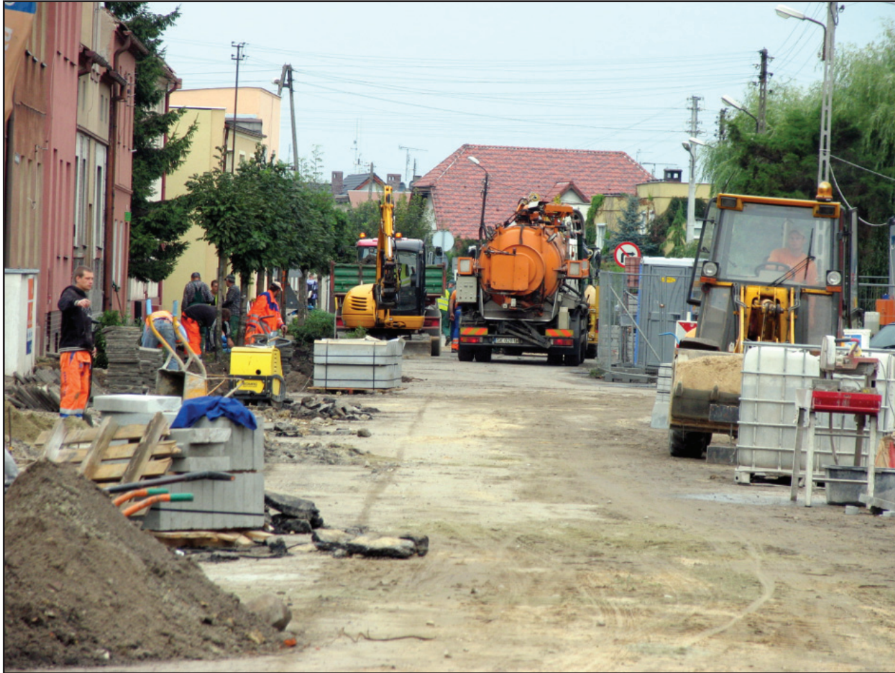
W tym roku trwają prace finansowane przez powiat na pierwszym odcinku ulicy Sierakowskiego. Dalsze prace na tej ulicy i na ulicy Koszewskiego będą realizowane w przyszłym roku.
