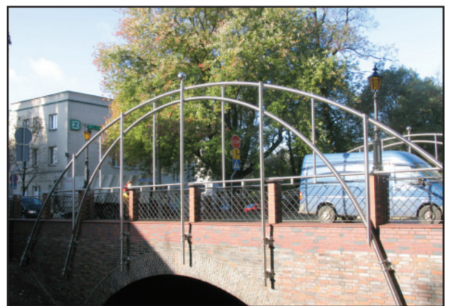
W Kościanie wyremontowano most i aleje T. Kościuszki.
