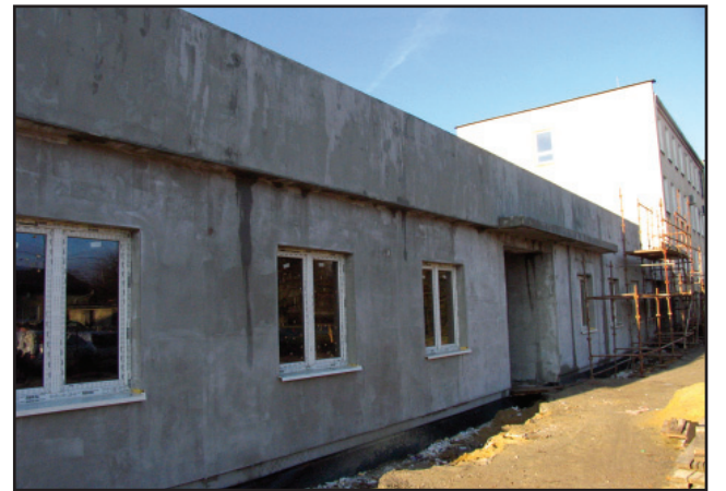
W tym roku zakończy się budowa nowej siedziby PCPR w Kościanie.
