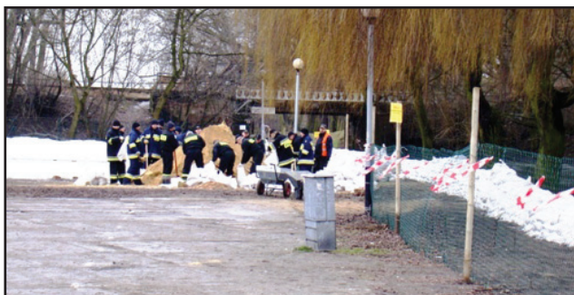
Prace przy umacnianiu wałów przy miejskim targowisku
