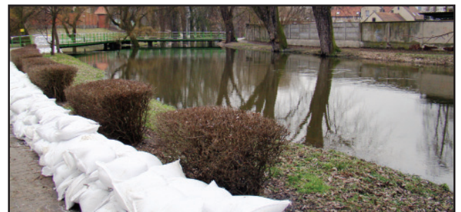
Umacnianie wału kontynuowano w sobotę 22 stycznia br.
