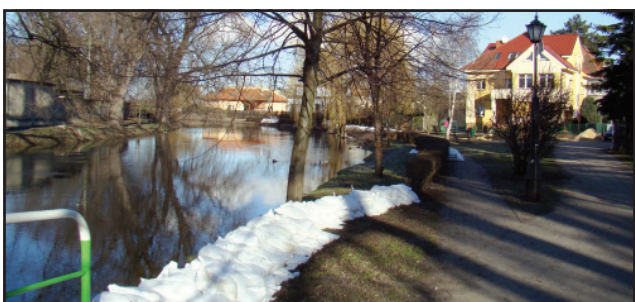
Kilkudziesięciometrowy deptak przy ul. Marcinkowskiego wzdłuż Kanalu zabezpieczono workami z piaskiem
