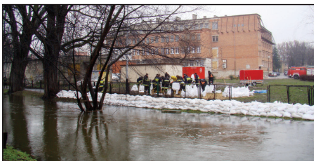
Prace przy podwyższaniu wałów przy trafostacji pomiędzy szpitalem a Al. Lipową
