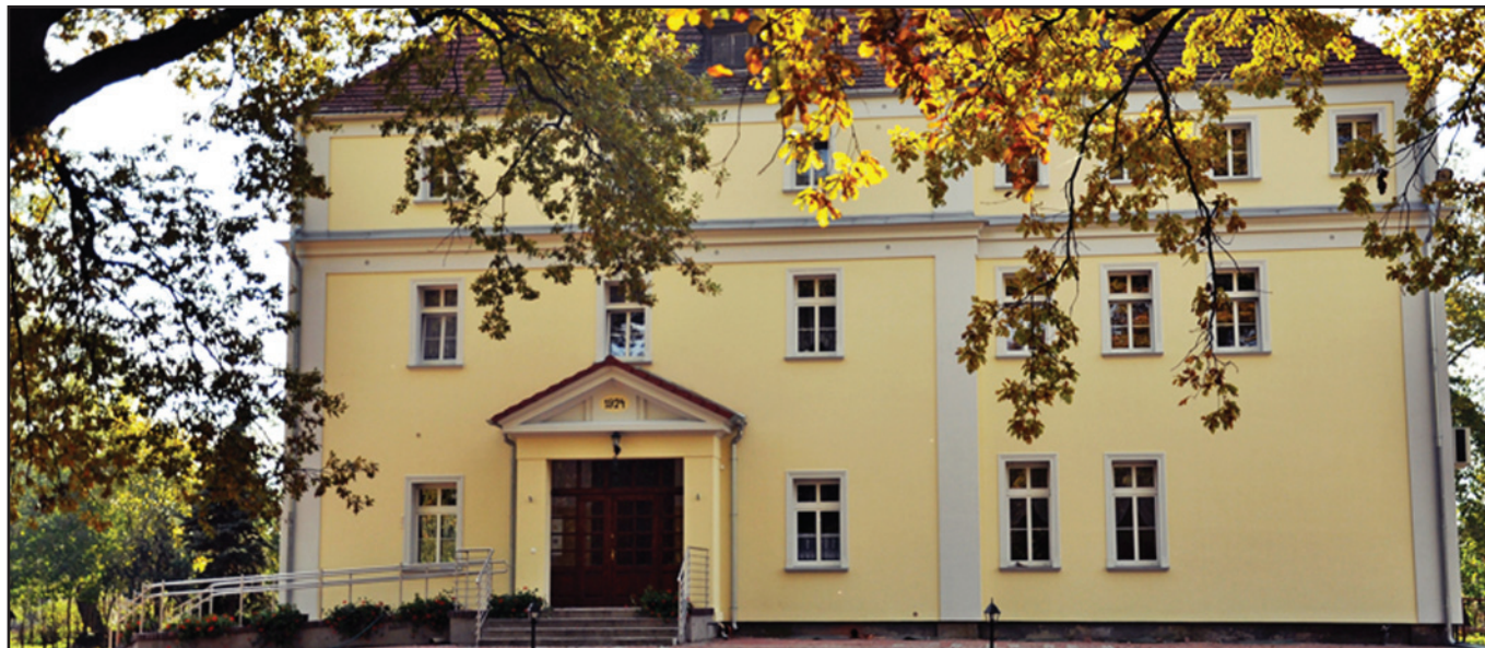
Wyremontowany pałac w Starych Oborzyskach
