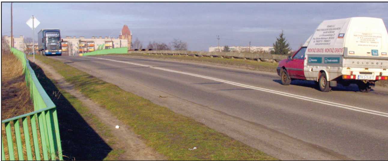
Wiadukt w Kościanie
